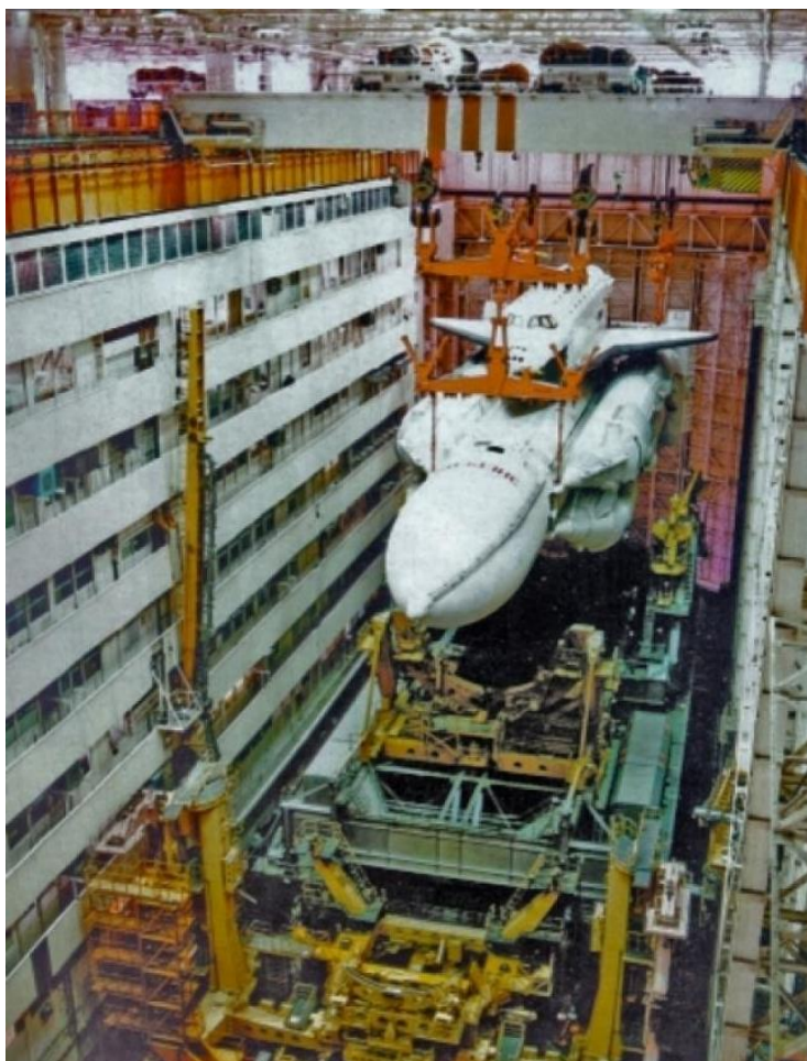
Рисунок 1.4 – Монтажно-испытательный корпус на космодроме Байконур [8]
